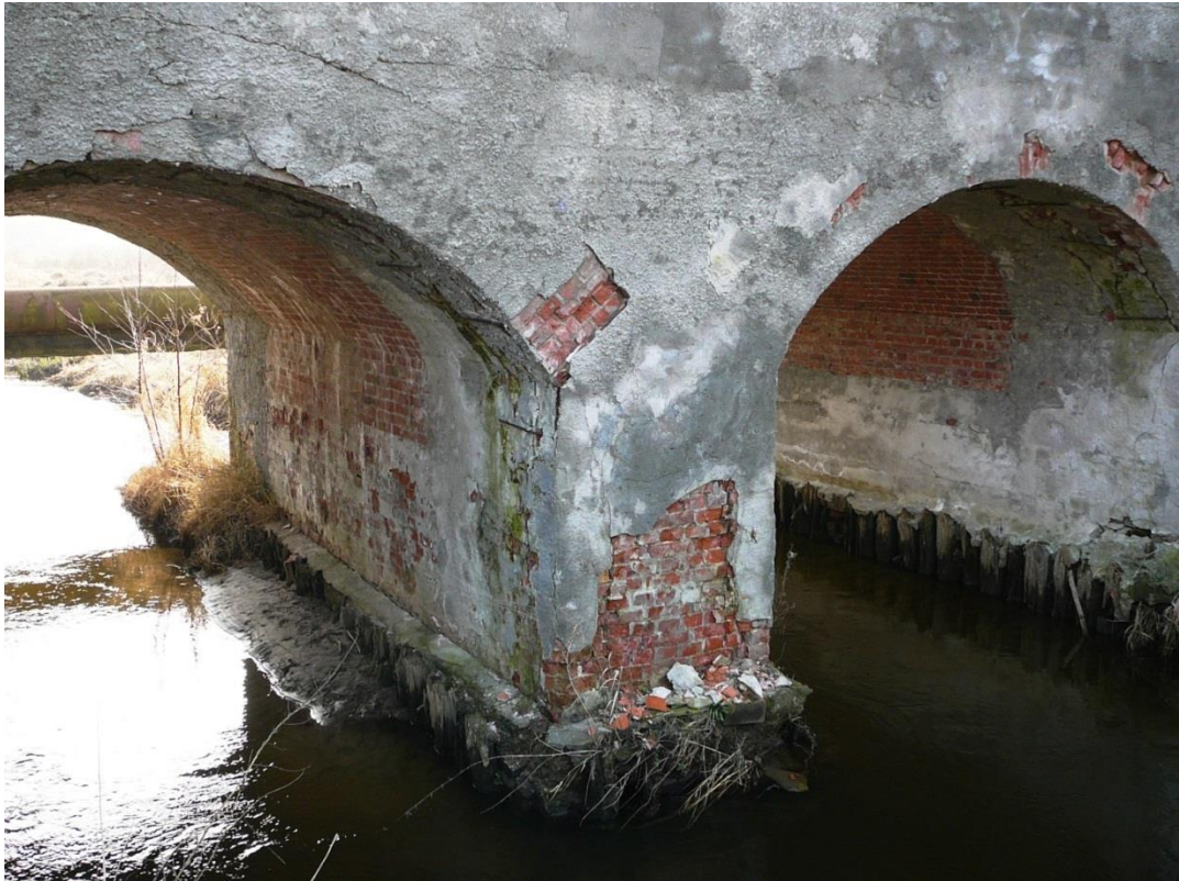
Fot. Nr.3. Widok mostu od strony WG.
