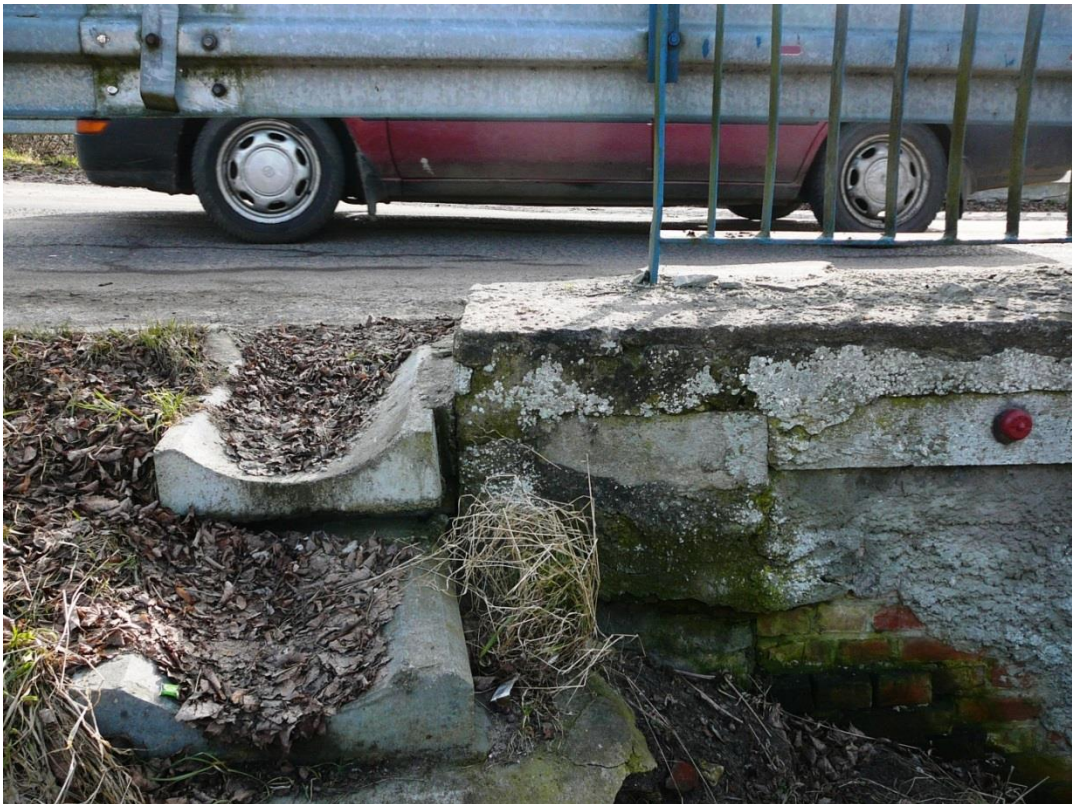
Fot. Nr.2. Lokalizacja punktu ściennego geodezyjnego od strony WG. Punkt kl. III – numer punktu 5007. H = 56,886
