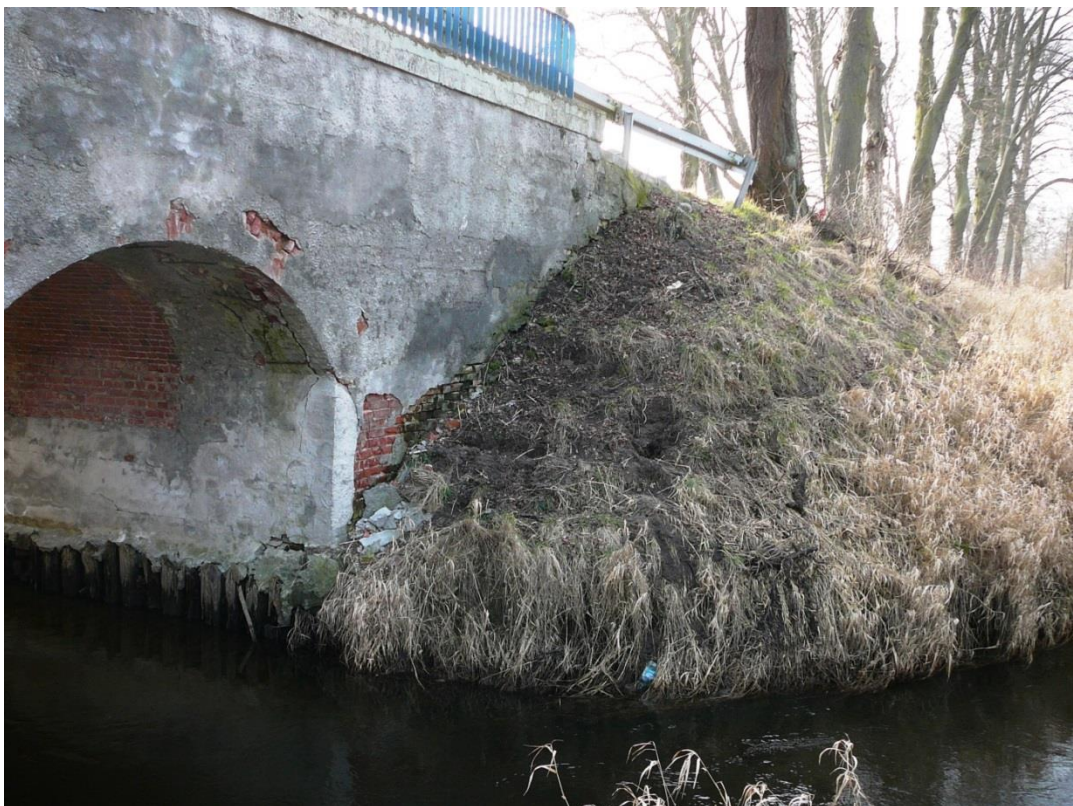
Fot.Nr.4. Przęsło i skarpa prawobrzeżna – widok od strony WG.
