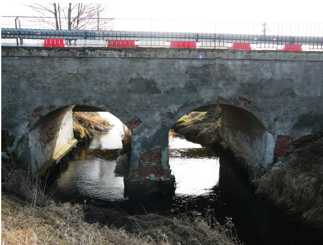
Fot. Nr.6. Widok mostu od strony WG.
