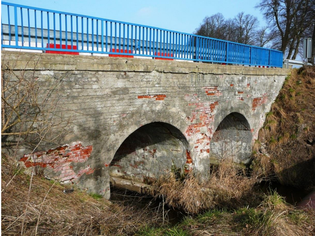
Fot. Nr. 9. Widok mostu od strony WD.
