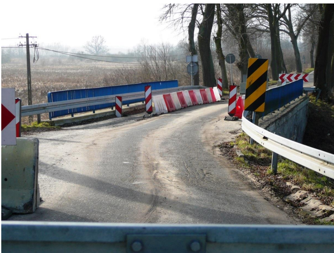
Fot. Nr.16. Dojazd do mostu od strony Radęcina.
