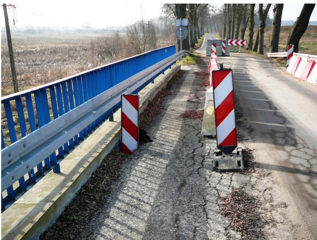
Fot. Nr.8. Widok jezdni od strony WD.
