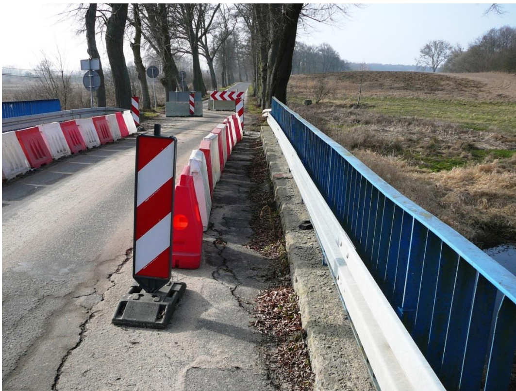
Fot. Nr.7. Widok jezdni od strony WG.
