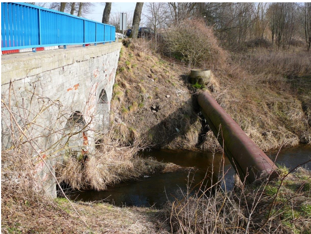
Fot. Nr.10. Widok mostu od strony WD. Wodociąg D=500 mm w rurze osłonowej D=800 mm.
