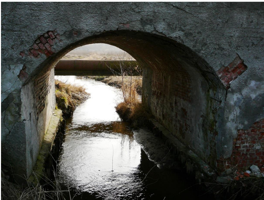
Fot.Nr.5. Przęsło lewobrzeżne – widok od strony WG.
