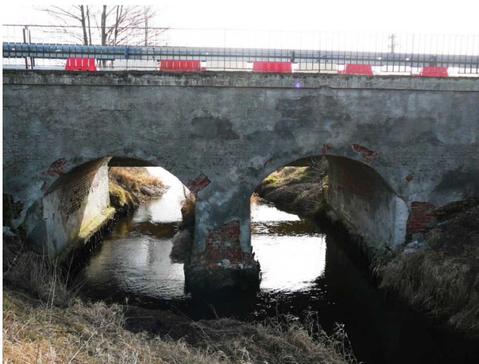
Fot. nr.4. Widok mostu od strony WG.
