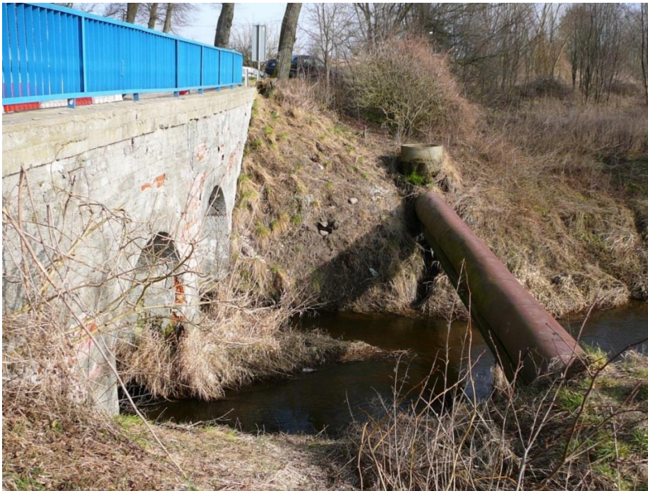
Fot. nr.4. Widok wodociągu w500 mm w rurze osłonowej D=800 mm od strony WD.
