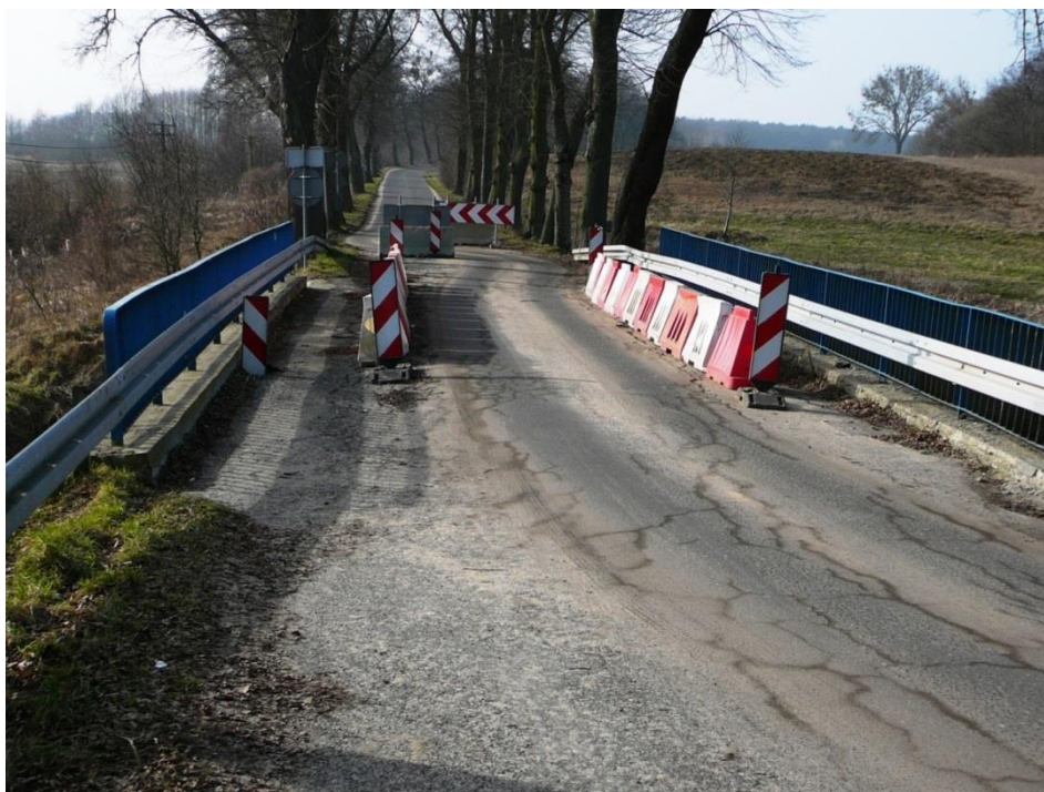
Fot. nr.1. Widok mostu w planie drogi powiatowej nr 1368 F.
