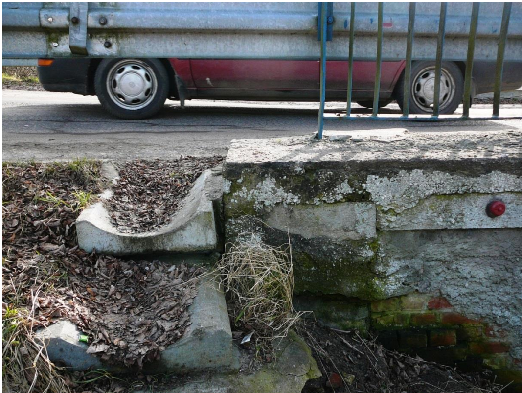
Fot. Lokalizacja punktu wysokościowego ściennego od strony WG.
