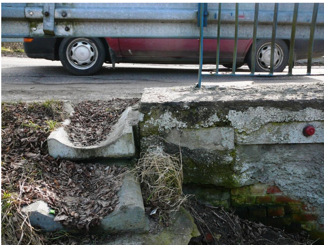
Lokalizacja punktu wysokościowego ściennego od strony WG.
