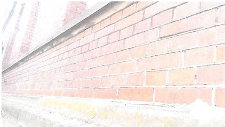
Fot. 5. Widok elewacji z gzymsem cokołowym z piaskowca.
