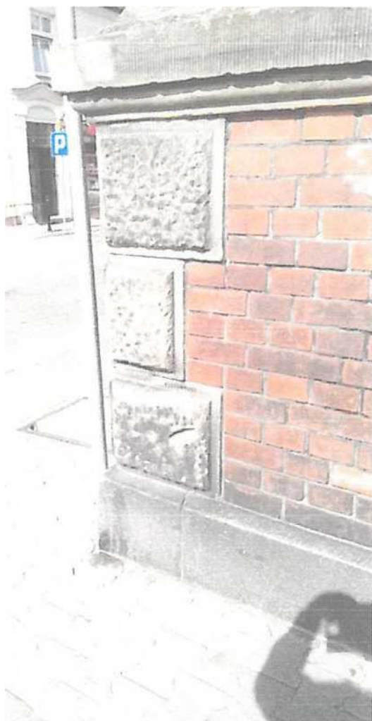
Fot. 6. Widok narożnika budynku w części cokołowej.
