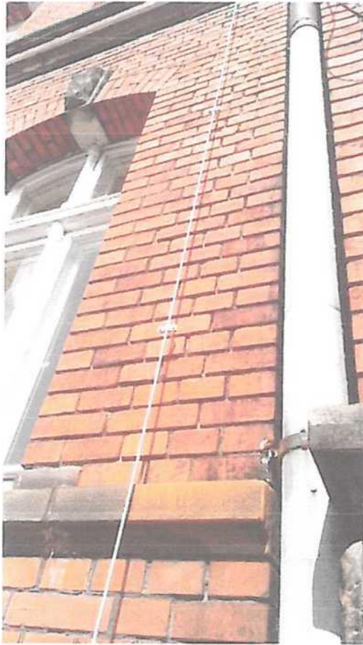
Fot 4. Widok fragmentu elewacji z cegły.
