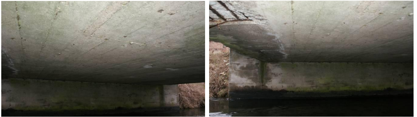
Grafika nr 6 – Stan wewnętrznych pasm płytowych
