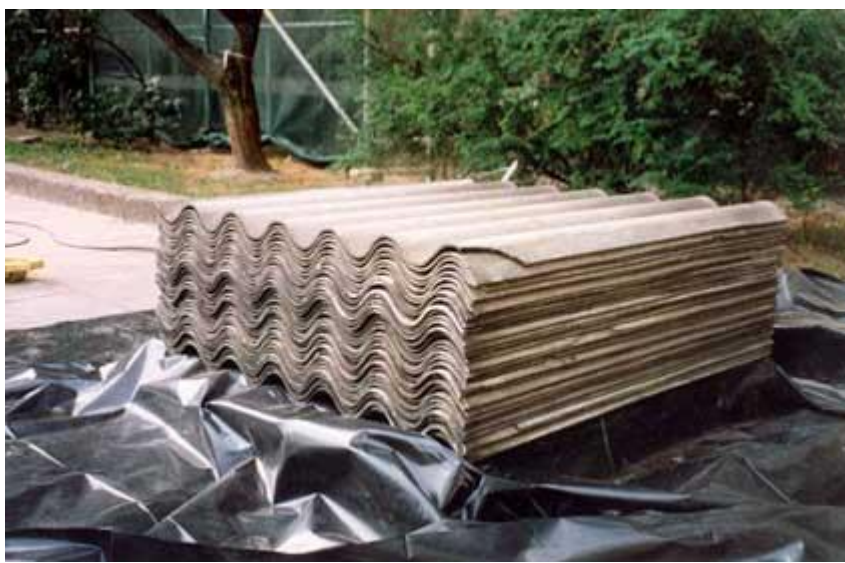
Rysunek 4 .Przygotowanie wyrobów azbestowych do transportu :
