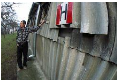
Rysunek 6. Ściana boczna budynku z płyt cementowo-azbestowych :
