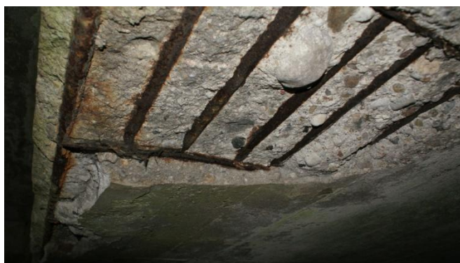
Grafika nr 3 – Stan płyty ustroju nośnego
