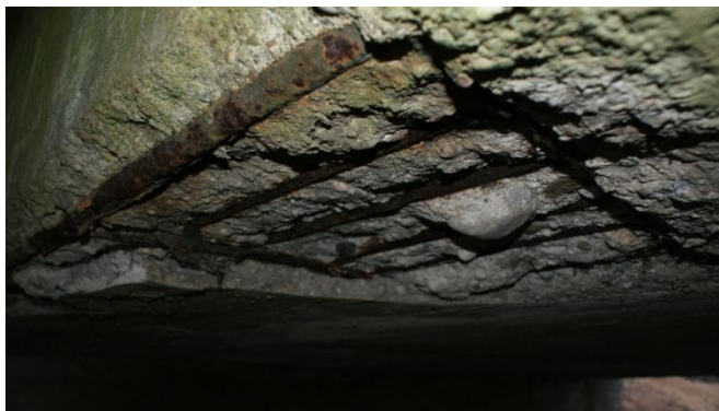
Grafika nr 3 – Stan płyty ustroju nośnego
