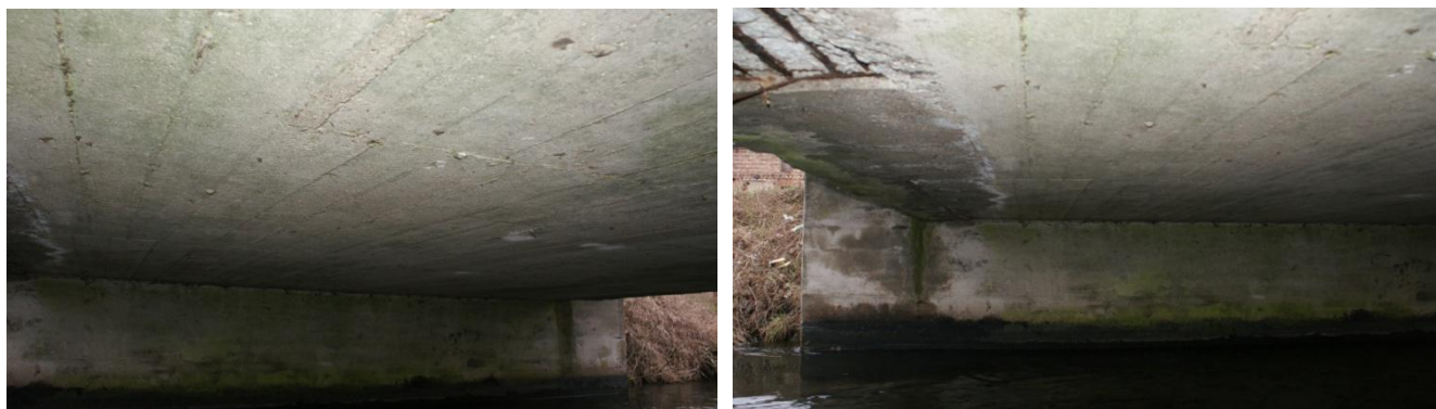
Grafika nr 6 – Stan wewnętrznych pasm płytowych
